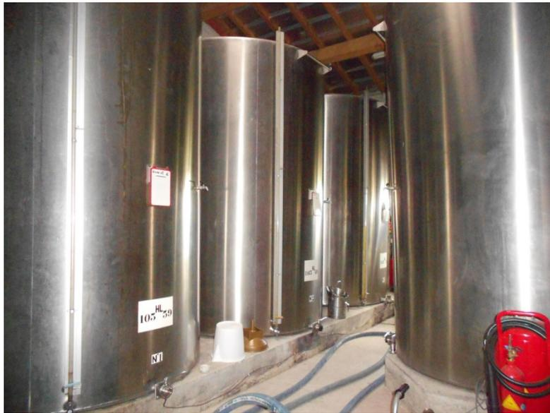
Le chai de distillation, d'une surface de 55 m<sup>2</sup>, est attenant à la distillerie. La Capacité Susceptible présente (QSP) de celui ci est de 50 m<sup>3</sup>. Il contient cinq cuves inox de 100 hl permettant de stocker le cognac à la sortie de l'activité de distillation. Il dispose d'une rétention interne, elle-même reliée à une rétention déportée de 50 m<sup>3</sup>.
